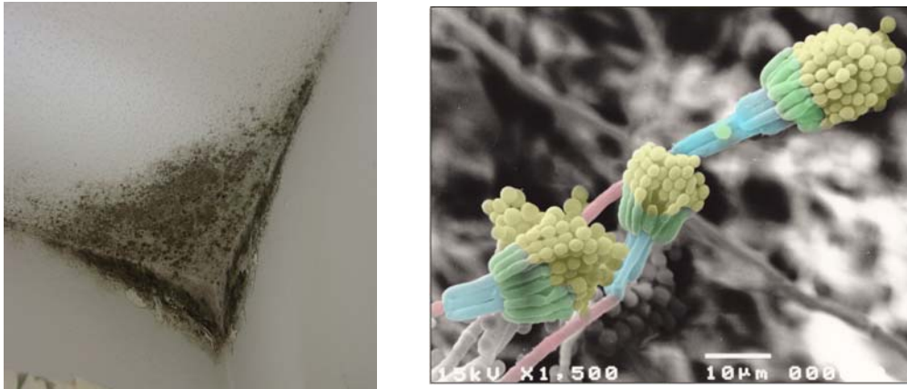
Bild 1: Verschimmelte Ecke eines Raumes aufgrund einer geometrischen Wärmebrücke (Bild links) sowie Rasterelektromikroskopische Aufnahme eines Pinselschimmels ( Penicillium sp.), nach [25] verändert (Bild rechts).
